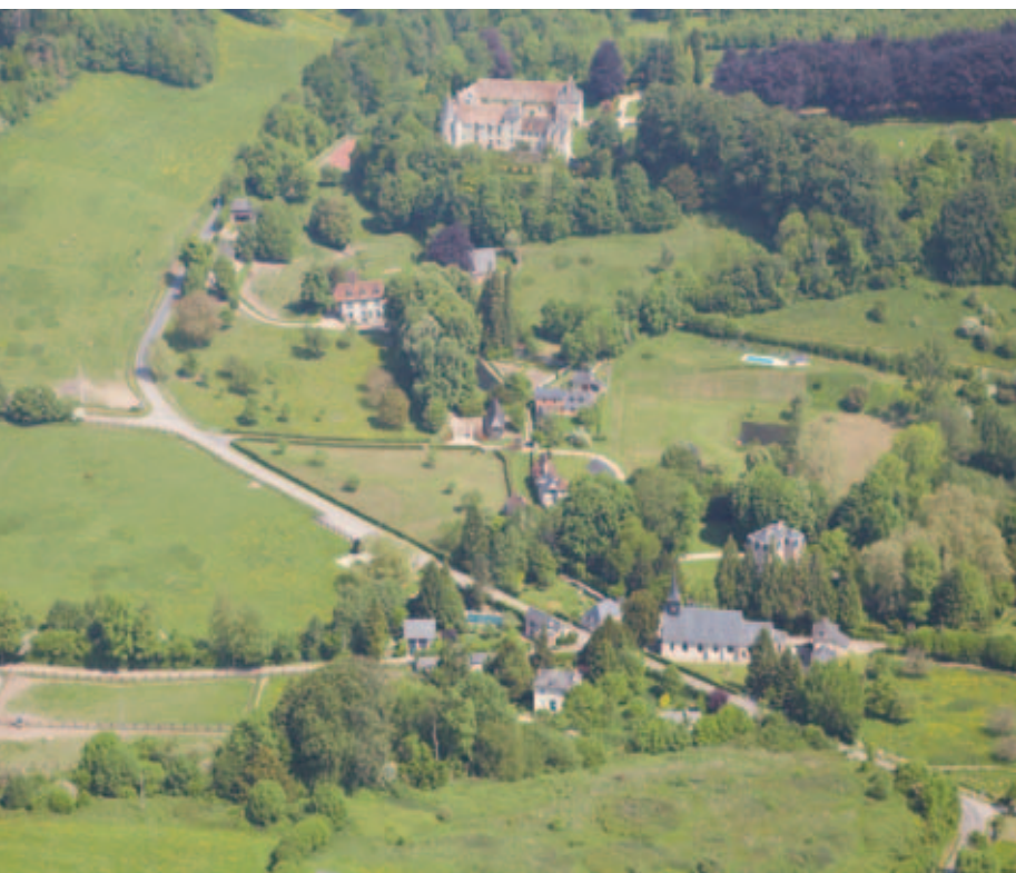
Le village d'OUILLY-DU-HOULEY, vue aérienne, 2009, Photo D. Letorey
