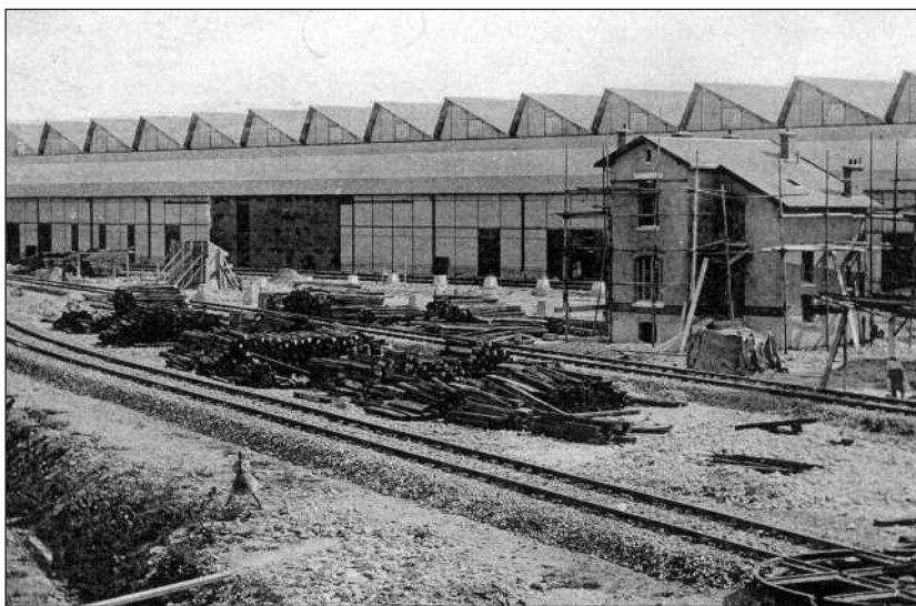
Les ateliers et le prolongement de la gare de triage de Mézidon-Canon. Vers 1914. Coll. part.
