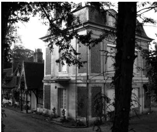
Manoir d'Argences à Saint-Martin-de-la-Lieue.
