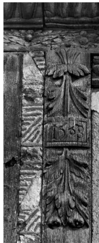
Cartouche portant la date de construction et détails de poutres sculptées. Vieux Manoir, Orbec.
