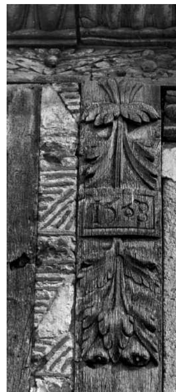
Cartouche portant la date de construction et détails de poutres sculptées. Vieux Manoir, Orbec.
