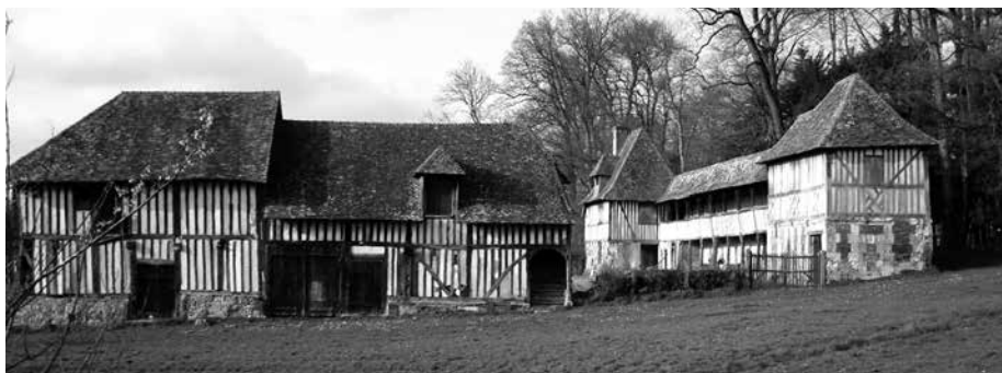
Fig. 2 - Lisieux, manoir des Mathurins : vue générale depuis le sud.
