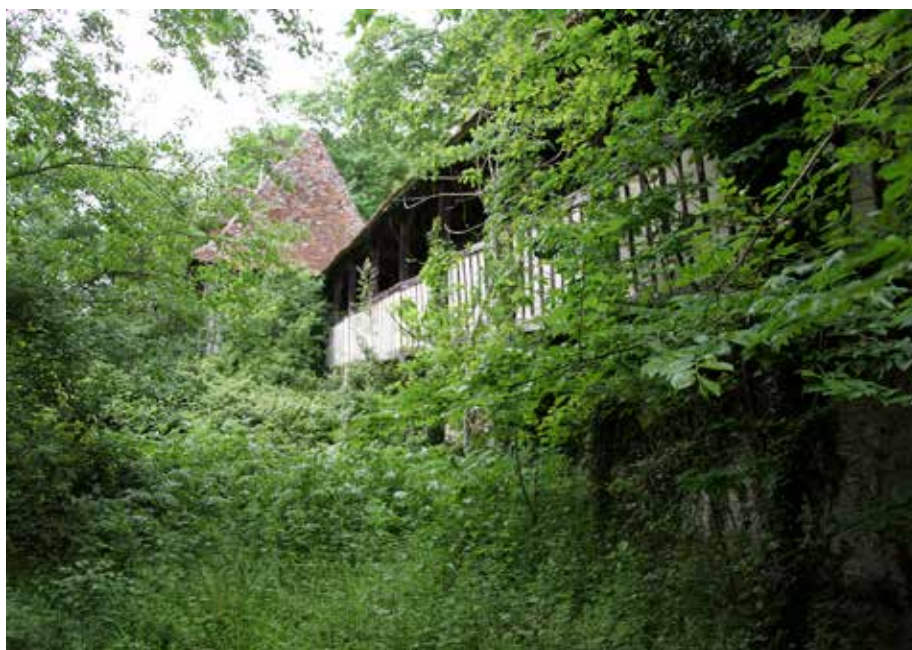
Fig. 6 - Lisieux, manoir des Mathurins : état actuel du logis, 2016.
