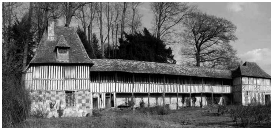
Fig. 4 - Lisieux, manoir des Mathurins : grand corps de logis, façade ouest.
